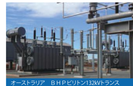
オーストラリア BHPビリトン132kVトランス
