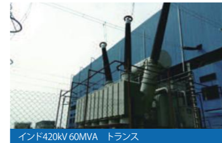
インド420kV 60MVA トランス
